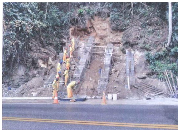
Figura 6.20 Rota 116 – Obra emergencial de contenção – km 44.1 Sul
