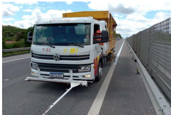
Figura 4.3 Via Lagos – Pintura de Faixas - Km 27+000 Sul
