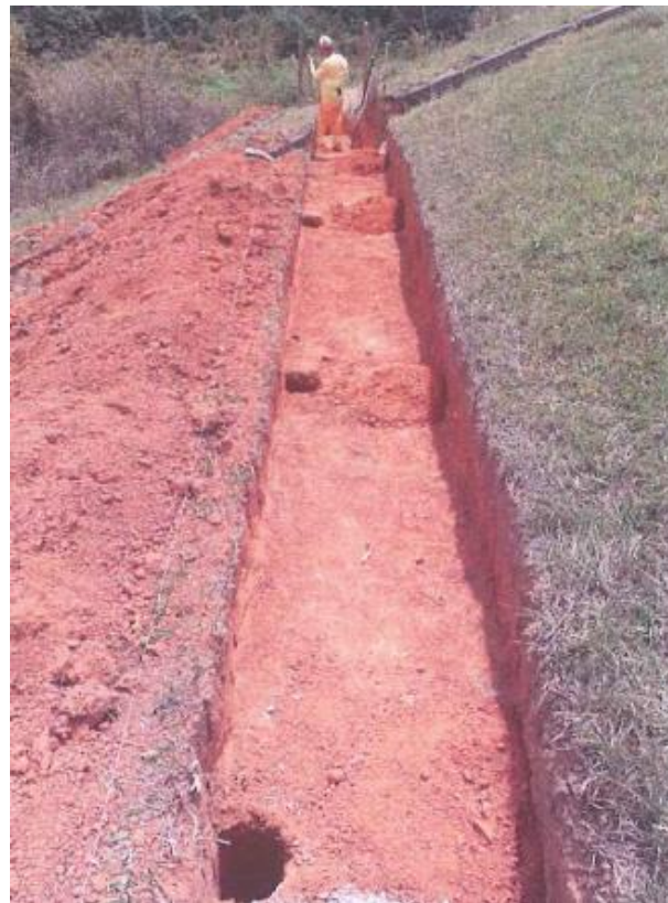
Figura 6.24 Recuperação de área degradada - km 136.5 Norte
