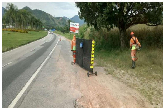
Figura 6.7 Via Lagos - Roçada Manual - Km 23+000 Sul
