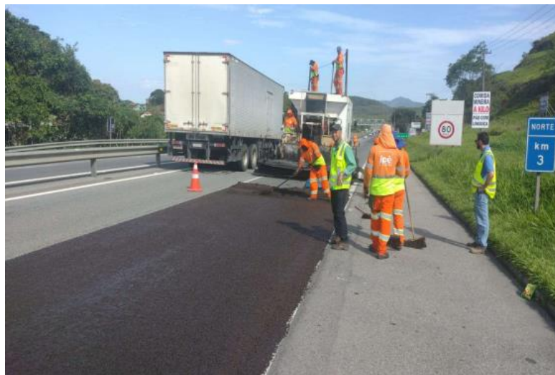
Figura 6.12 Via Lagos – Microrevestimento - Km 3+000 Norte
