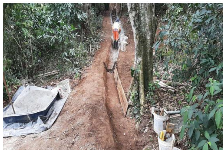
Figura 6.10 Via Lagos – Implantação de drenagem superficial - Km 07+400 Sul
