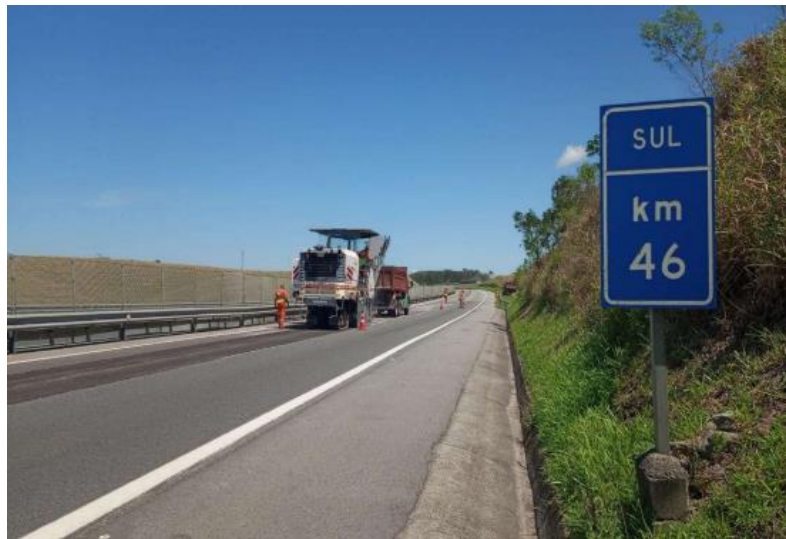
Figura 6.14 Via Lagos – Micro fresagem - Km 46+000 Sul
