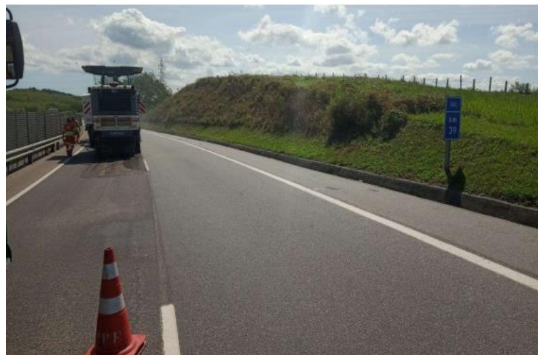
Figura 6.15 Via Lagos – Micro fresagem km 39+000 Sul
