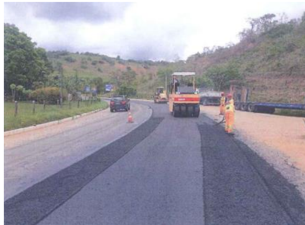
Figura 6.22 Rota 116 – Recapeamento de pavimento – km 137
