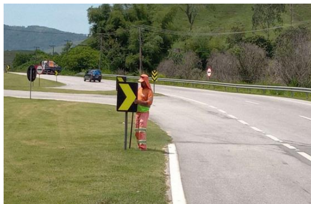
Figura 6.4 Via Lagos – Nivelamento de Placa - Km 7+300 Norte
