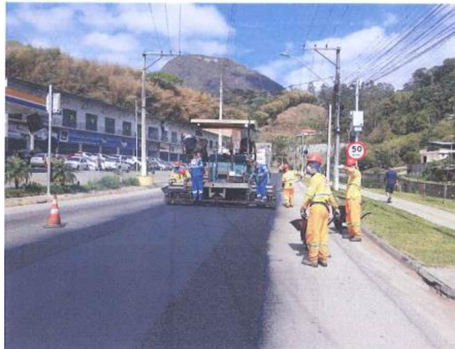
Figura 6.21 Rota 116 – Recapeamento de pavimento – km 83.5 ao 84
