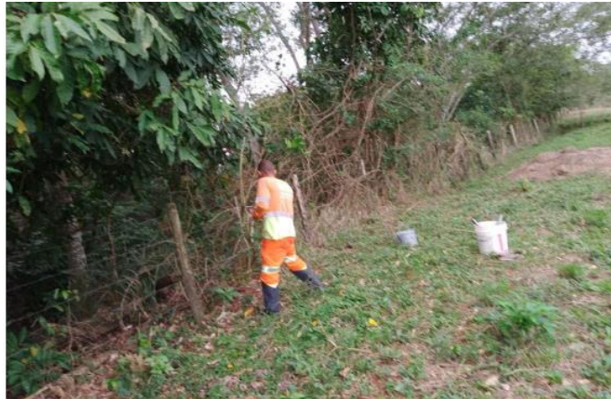
Figura 6.8 Via Lagos – Reparo de Cercas - Km 38+100 Norte
