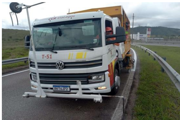
Figura 6.2 Via Lagos – Pintura de Faixas - Km 56+800 Norte
