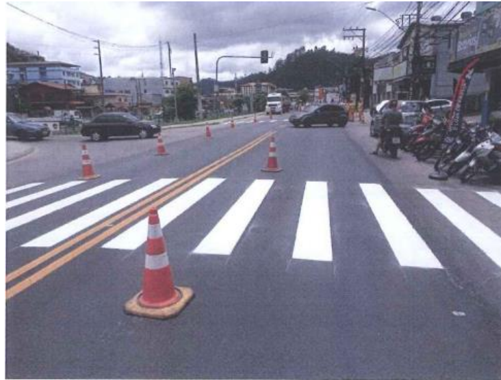
Figura 6.18 Rota 116 – Pintura de faixa de pedestre – km 83 ao km 85
