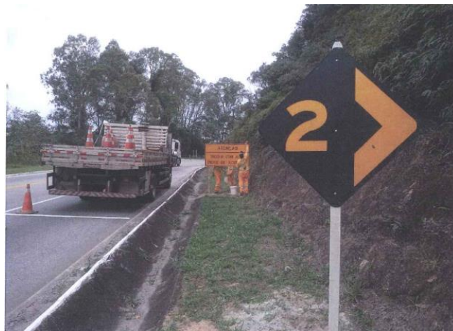
Figura 6.19 Rota 116 – Sinalização horizontal e vertical – km 61
