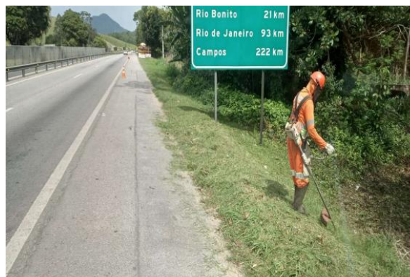
Figura 4.6 Via Lagos – Roçada Manual - Km 21+000 Sul
