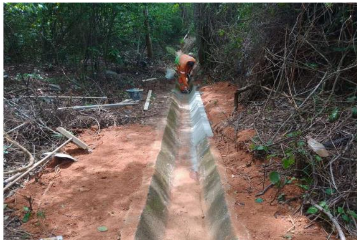
Figura 4.5 Via Lagos – Recuperação de Valeta de Corte - Km 35+200 Sul
